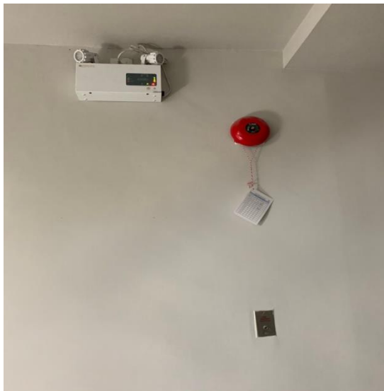
รูปที่ 25 รูปเครื่องแจ้งเหตุ และ กริ่งสัญญาณเตือนอัคคีภัย
